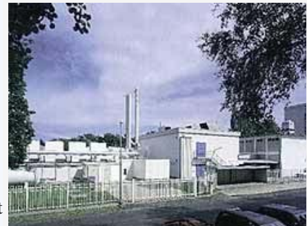
Prüffeld aus mehreren Modulprüfständen, die zu einem Gebäude zusammengesetzt wurden
